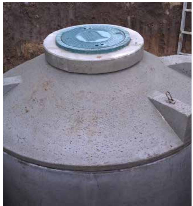
Et karakteristika ved WS bioclean™ er det lille, kørefaste dæksel.
