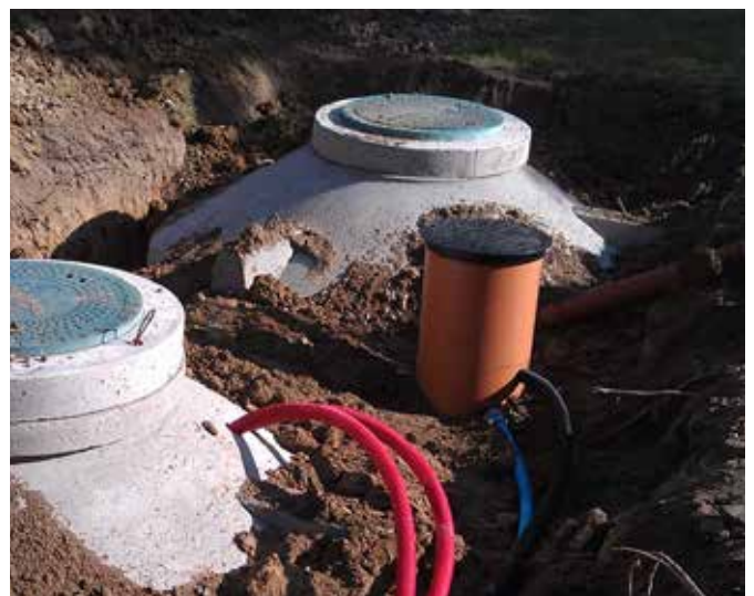
Etablering af WS bioclean 15 PE minirenselanlæg, svarende til 4 husstande.
